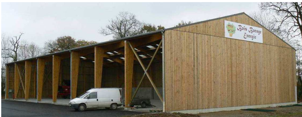
Plateforme de stockage de bois – Athis-de-l'Orne
